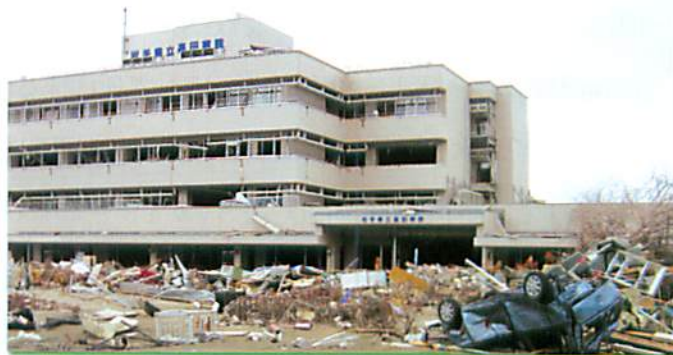
4階まで浸水した岩手県立高田病院（陸前高田市）
