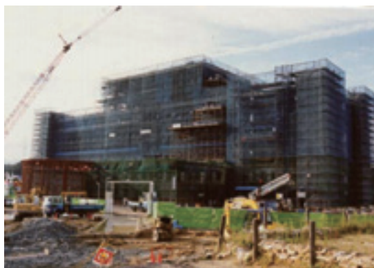
(建築中の病院)
