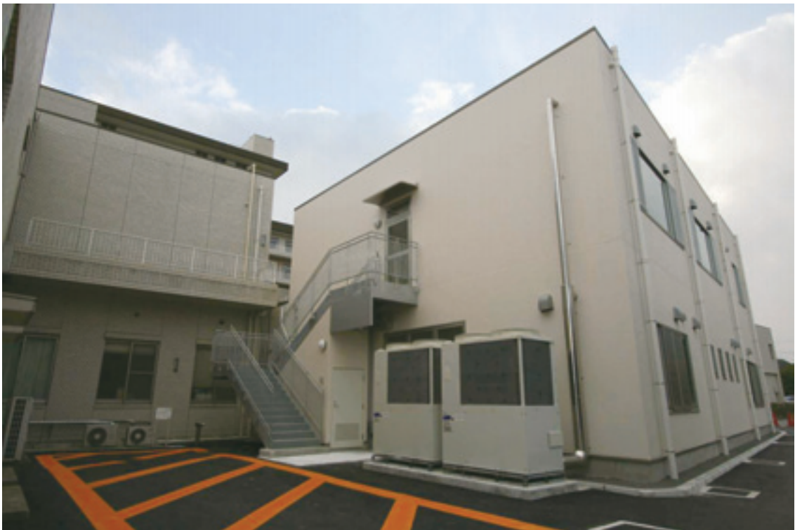
内視鏡棟増築外観（平成25年2月撮影）
