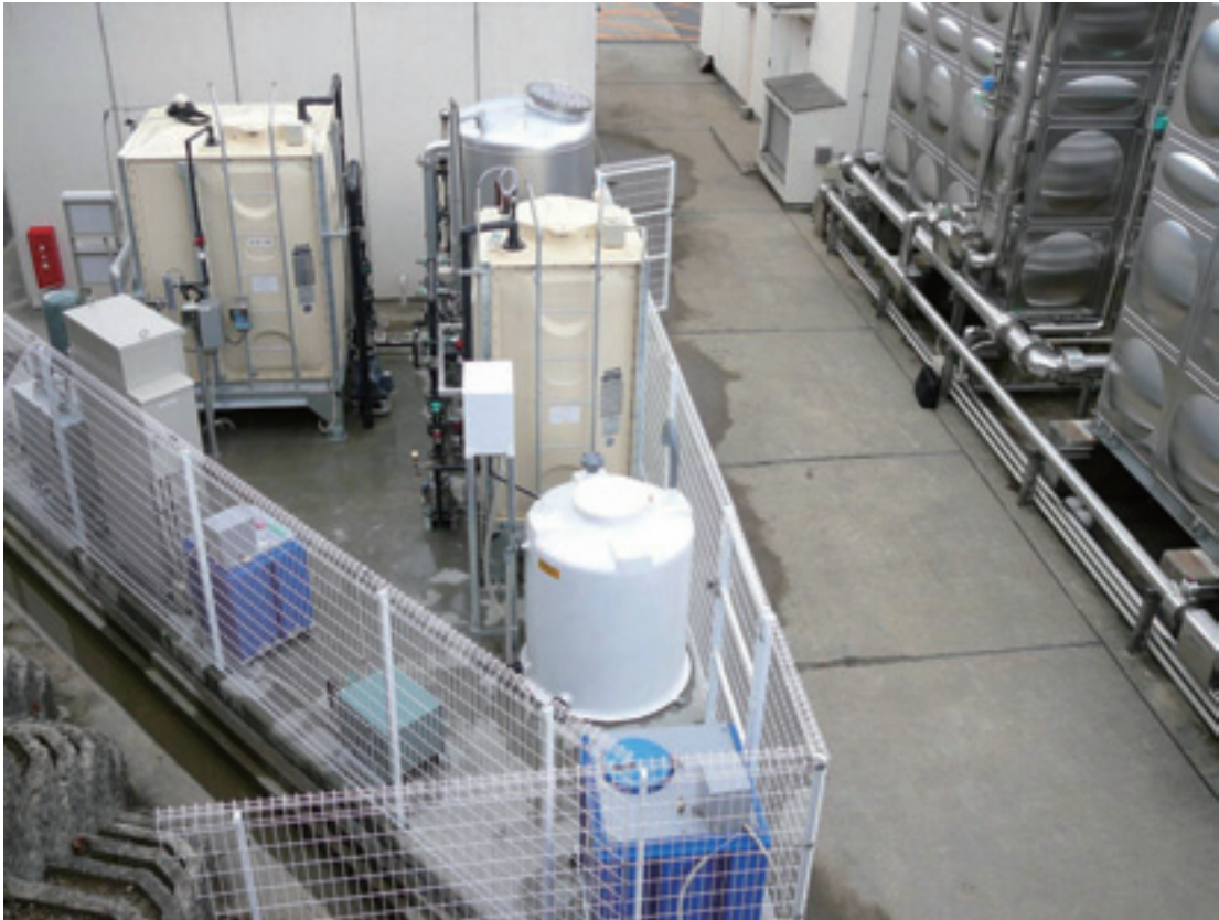
災害用地下水供給システム設置（平成20年3月撮影）
