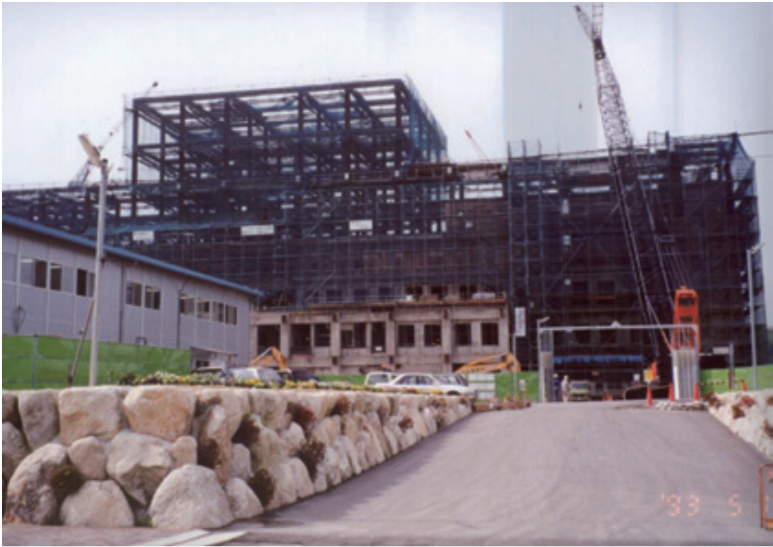
建築工事中（平成5年5月撮影）
