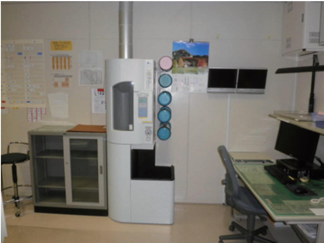
気送管システム導入（平成23年11月撮影）
