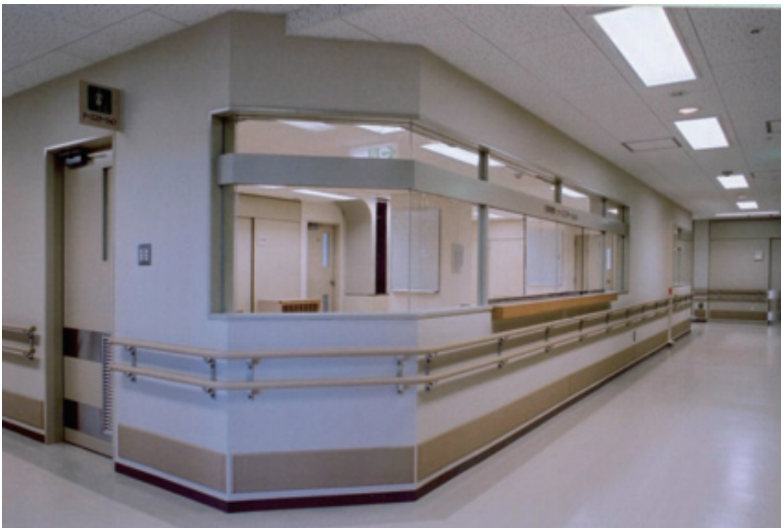
6 東病棟改修工事「ナースステーション」（平成13年2月撮影）
