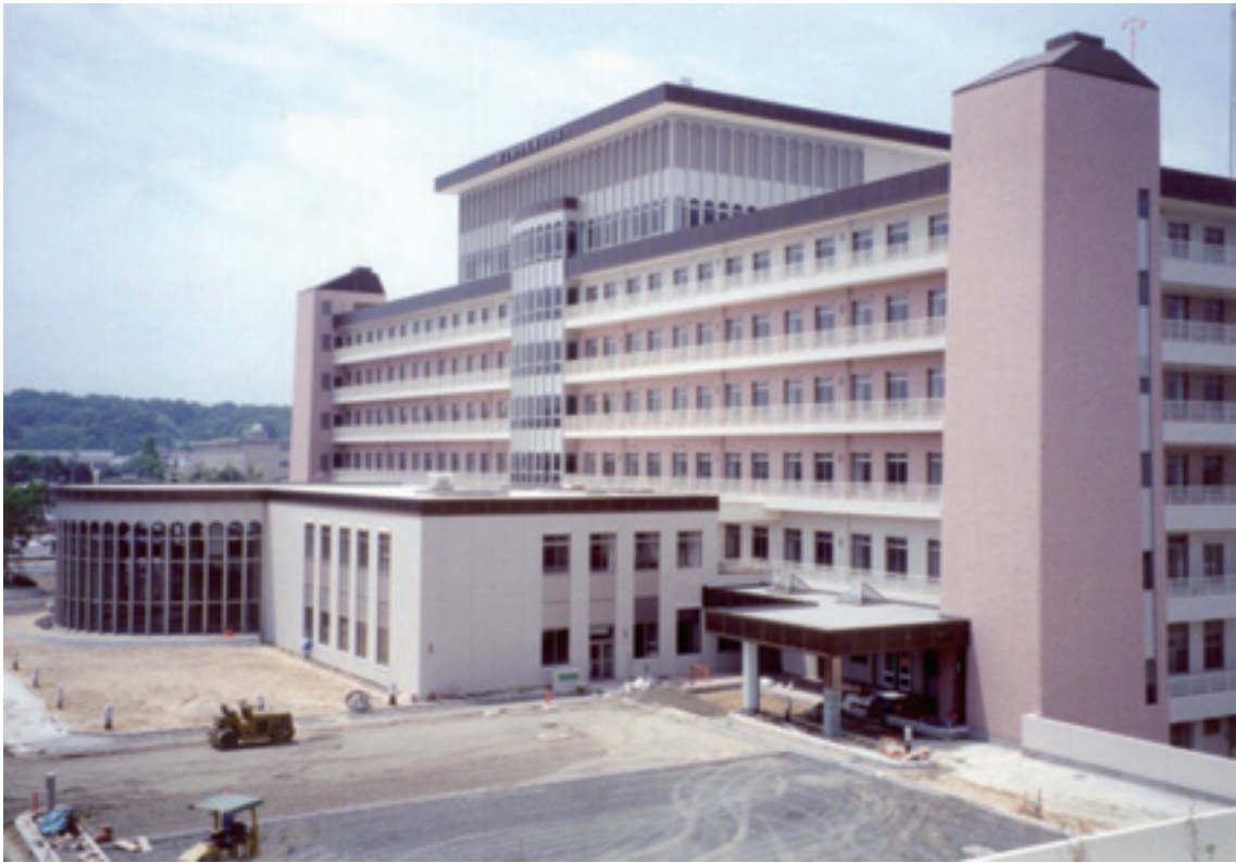
建築工事中（平成6年6月撮影）
