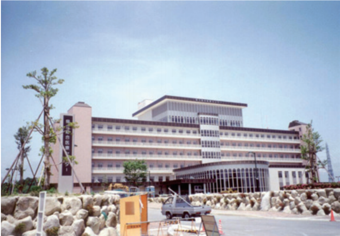
建築工事中（平成6年6月撮影）
